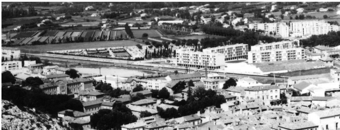
Le quartier des Condamines en construction, vers 1965. AMC, 6Fi10.
